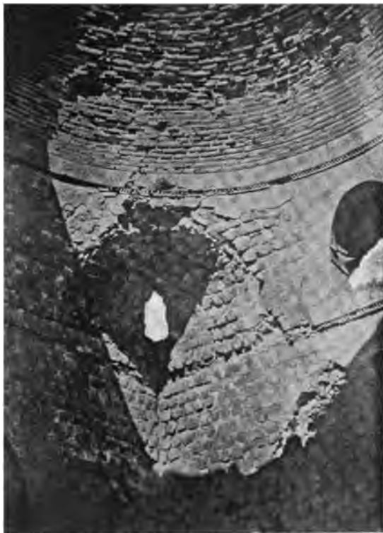
Fig. 130. — Salle couverte en coupole au Palais de Sarvistan (Perse). Raccordement par une trompe conique des murs rectangulaires avec la coupole.
